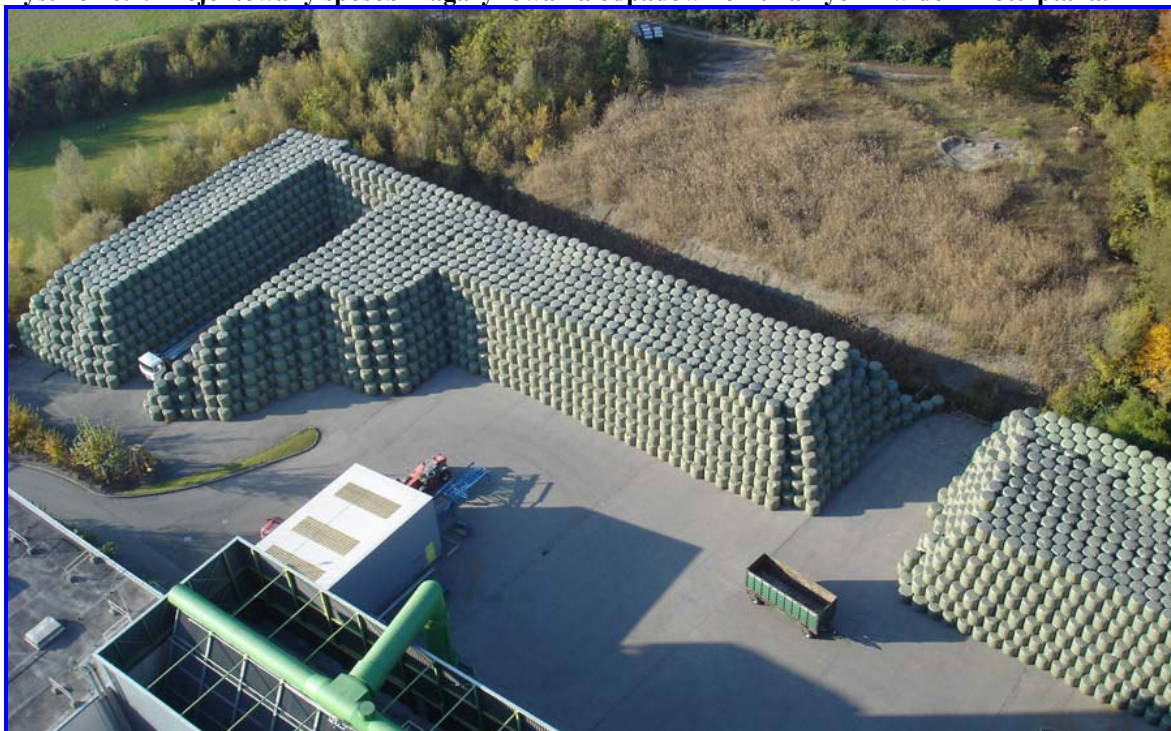
Rysunek 6.2. Projektowany sposób magazynowania odpadów komunalnych – widok z lotu ptaka.
