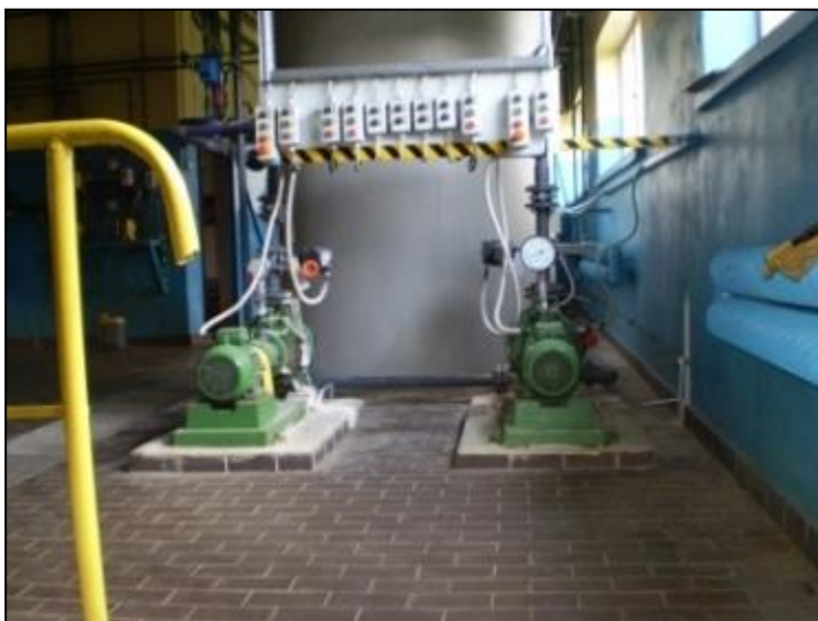
Rysunek 29. Układ pomp dozujących mleka wapiennego Źródło: SEEN
